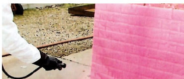
Recouvrement par pulvérisation du gel POLYNEC sur la surface contaminée
