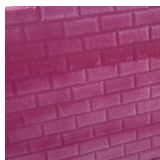
Recouvrement par pulvérisation du gel POLYNEC sur la surface contaminée
